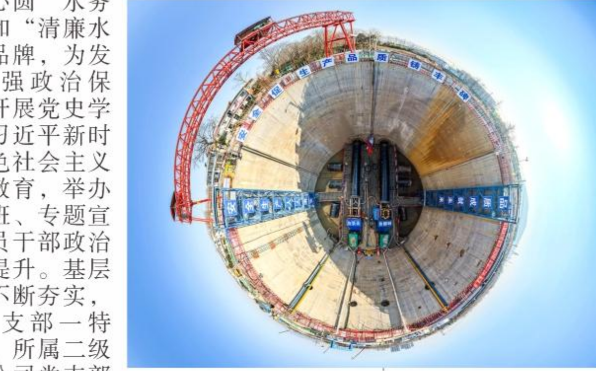
花湖水厂二期工程正在紧张施工
